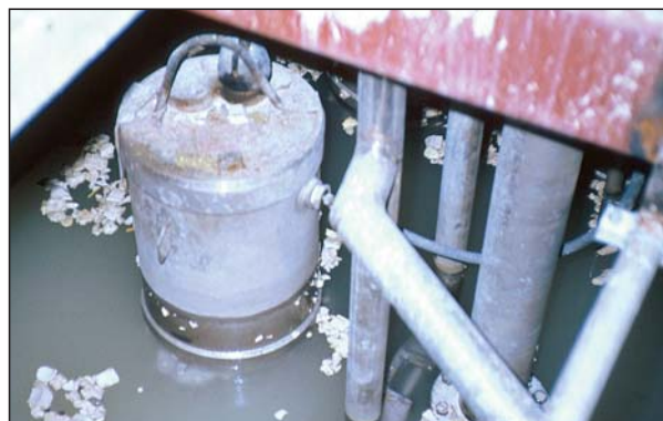
Фото 1: Один из двух насосов Grundfos из нержавеющей стали используется для перекачивания пигментосодержащей воды с плотностью 1,0 – 1,4 кг/дм 3 и максимальной вязкостью 250 мПа·с. Оба насоса оснащены запатентованной системой промывки торцевых уплотнений вала.
